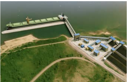
Комплекс перевозки угля «Лавна»
